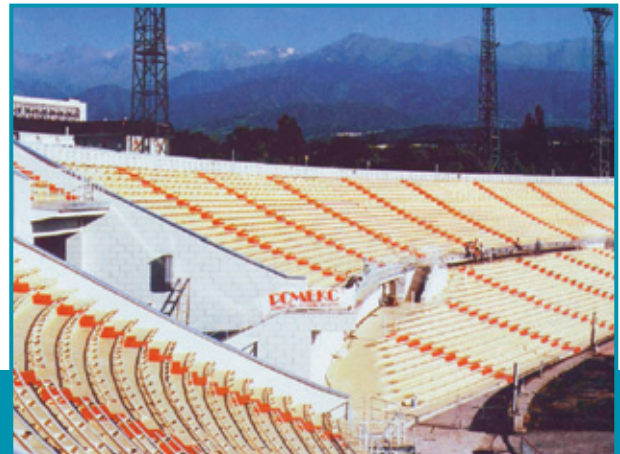
Zentral stadium, Almaty / Kasachstan
